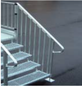
Geländer Typ 4 mit U-förmigen Geländerende
